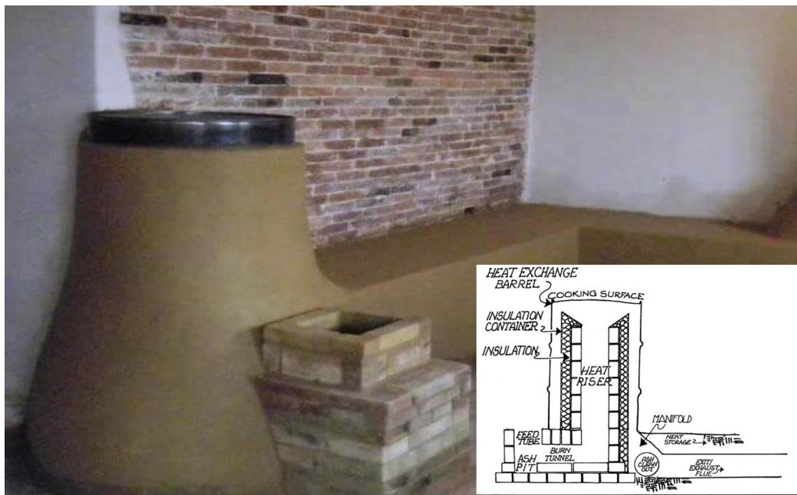
Sur le site expérimental de Jumilhac-le-Grand (24), le modèle de Rocket Stove installé dans une maison bioclimatique est basé sur un conduit de 153 mm et chauffe entièrement la surface de 100 m<sup>2</sup> au sol avec une hauteur sous plafond de plus de 7 mètres. Cette maison construite en ballots de paille est évidemment très bien isolée. Il n'en demeure pas moins que le chauffage au Rocket Stove y est très efficace<sup>1</sup>.
